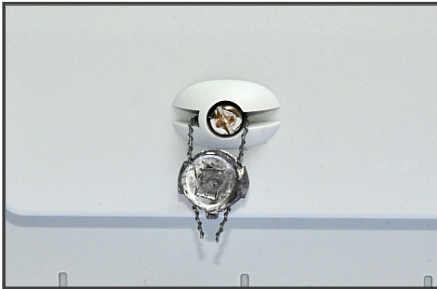
Abb. oben: Benutzersicherung für den Klemmendeckel (per Plombe)
